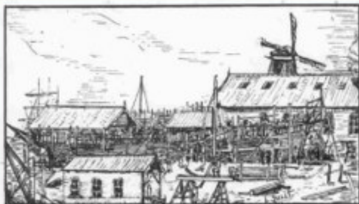
Bark „Eersteling“ in aanbouw, werf J.K. Smit 1847-48 eerste schip door J.K. Smit Kinderdijk - eerste schip voor M.L. Els. - op stapel in de haven - die is - afgedamd en drooggelegd -
